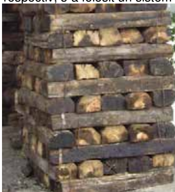
Figura 7. Calaje din stejar utilizate la ridicarea podului de pe râul Moldova din localitatea Tupilați, jud. Neamț
