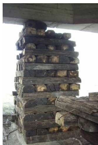
Figura 8. Ridicarea în trepte a tablierului intermediar al podului de pe râul Moldova, localitatea Tupilați, km. 34+312, județul Neamț
