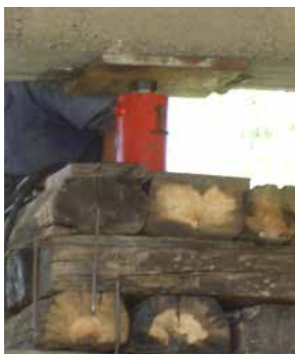
Figura 8. Ridicarea în trepte a tablierului intermediar al podului de pe râul Moldova, localitatea Tupilați, km. 34+312, județul Neamț
