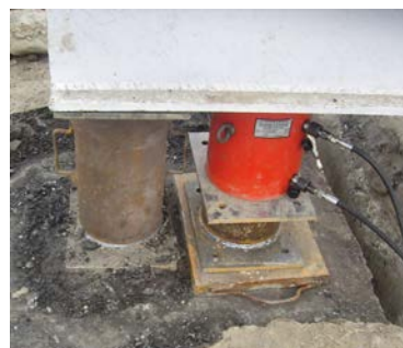
c) Poziționarea cilindrului hidraulic sub grinda de ridicare
