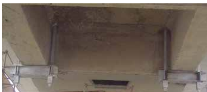
b) Fixarea tablierului podului cu ajutorul tiranților și a grinzilor metalice (jug)
